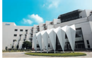
Tainan Fabrika (Elmas Sınıfı Yeşil Bina)
